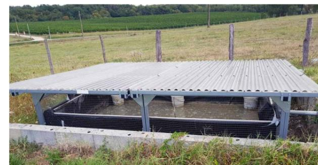
Bac de rétention des effluents viticoles associé à une aire de lavage
